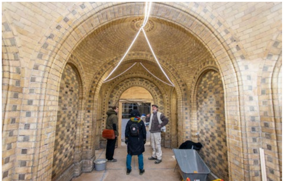
Indgangen til Sætatens Pigeskole er et overflødhedshorn af mønstermurværk og loftshvælvinger med rosetter.
