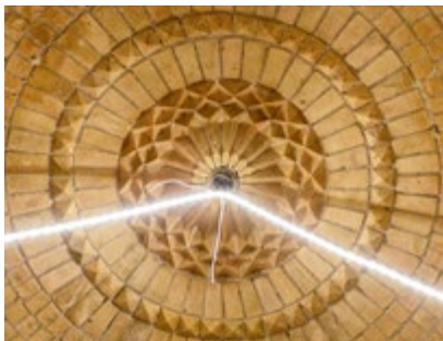
Murede loftshvælvinger med forskellige murede rosetter. (Den hvide stribe er belysning opsat mens der bliver arbejdet.)
