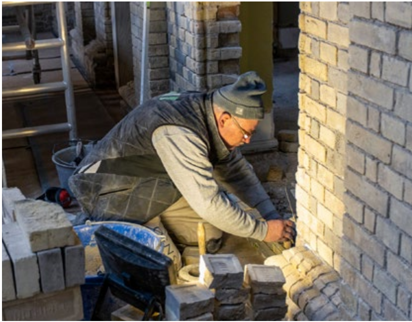
De gamle dørhuller skal reetableres og stenene tages forsigtigt ud, så de kan blive genbrugt andre steder.
